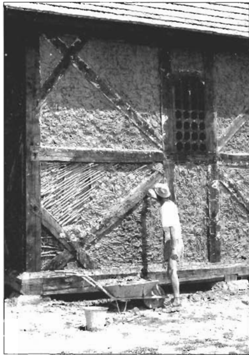
A templom sövényfalának tapasztása The pasting of the church's wicker-wall
