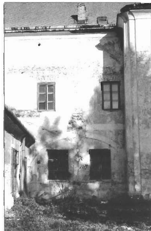
Az udvari homlokzat részlete a befalazott barokk árkádokkal A section of the facade at the backyard with the bricked-in Baroque archway
