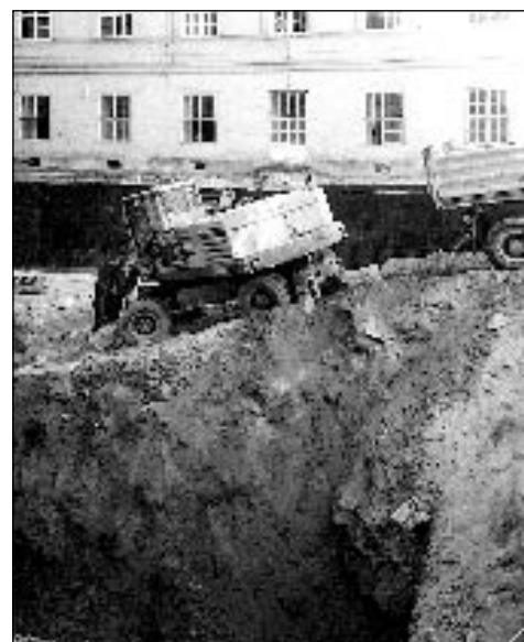
A föld kiemelése a Lapidarium építéséhez Excavating earth for the construction of the Lapidarium
