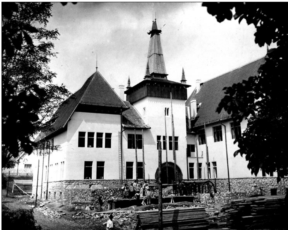
A székhely építése közeledik a vége felé, 1912 Towards the end of the construction works, 1912
