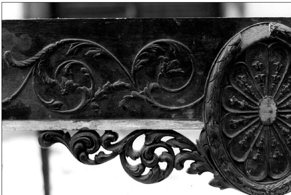
A ragasztás elöregedése folytán hiányossá vált ornamentika The incomplete ornamentation owing to the aging of the adhesive
