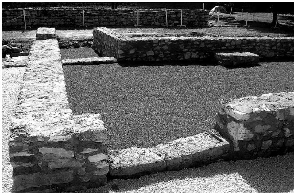
A XXIX. épület déli része a romkonzerválást követően The southern part of building XXIX. after ruin conservation
